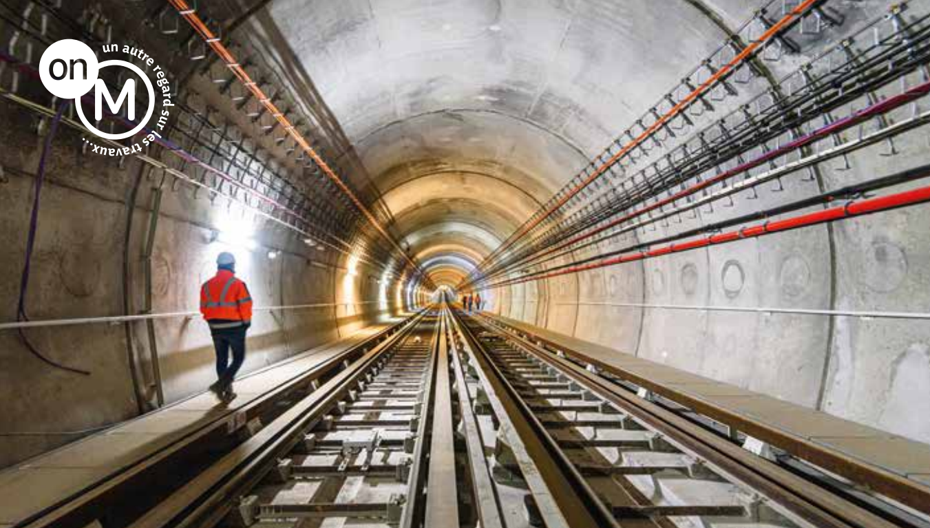
Balade en sous-sol entre Barbara et Bagneux–Lucie Aubrac, pour Rachid Louannoughi, le chargé d'info du projet, qui remonte le tunnel finalisé entre les deux nouvelles stations de la ligne 4, en mars 2021.
