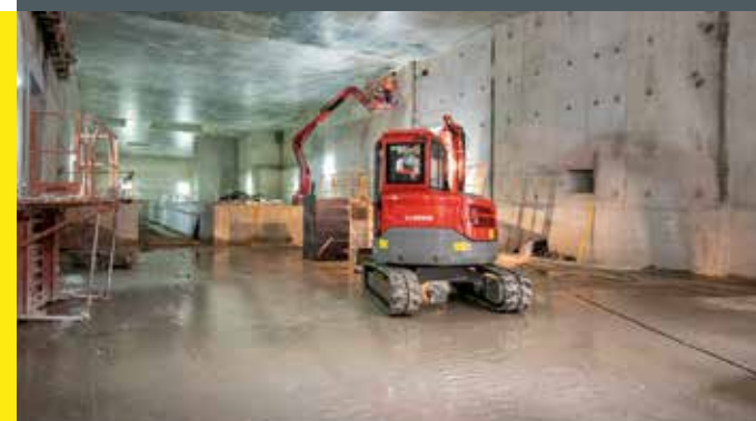
Centre de dépannage des trains
